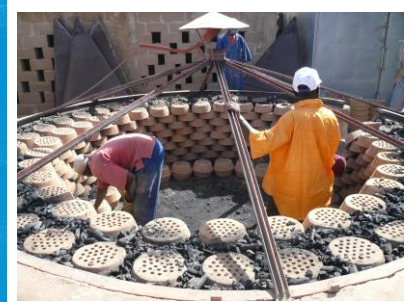
Insgesamt werden im Rahmen des Projekts in 10 Jahren 300.000 Öfen gebaut.
